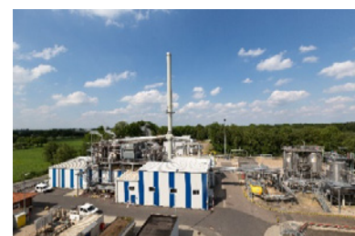
Паронагнетательная установка в Эмлиххайме генерирует горячий пар, который улучшает извлекаемость нефти в пласте-коллекторе.
