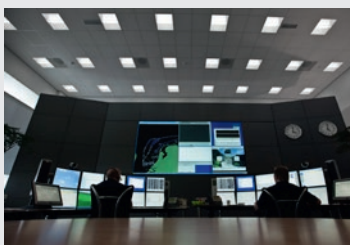
Zentrale für Remote Control Operations: Wintershall steuert ihre niederländischen Gasplattformen mit modernster Funktechnologie von Land.
